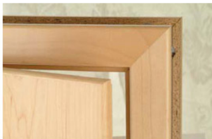
Coupe à 45° irréprochable dans les chambranles de porte.
